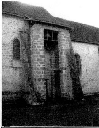
Des piliers en pierres ont été rétablis pour supporter le porte cloche
